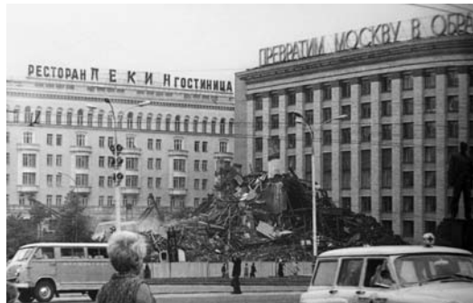
Снос театра «Современник» на площади Маяковского
