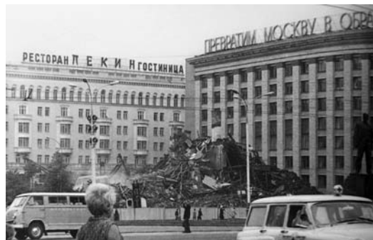
Снос театра «Современник» на площади Маяковского
